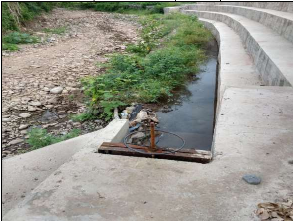
Fotografía No 5 Compuerta para canal de derivación del último tramo de agua en el cauce del río (Coordenadas 1099421.3E, 1635403.30N )
