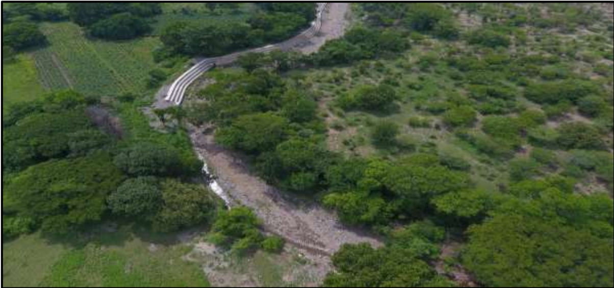
Fotografía No 1 Vuelo con Drone evidencia del último tramo de agua en el cauce del río Chiriaimo en el inicio del muro de contención.
