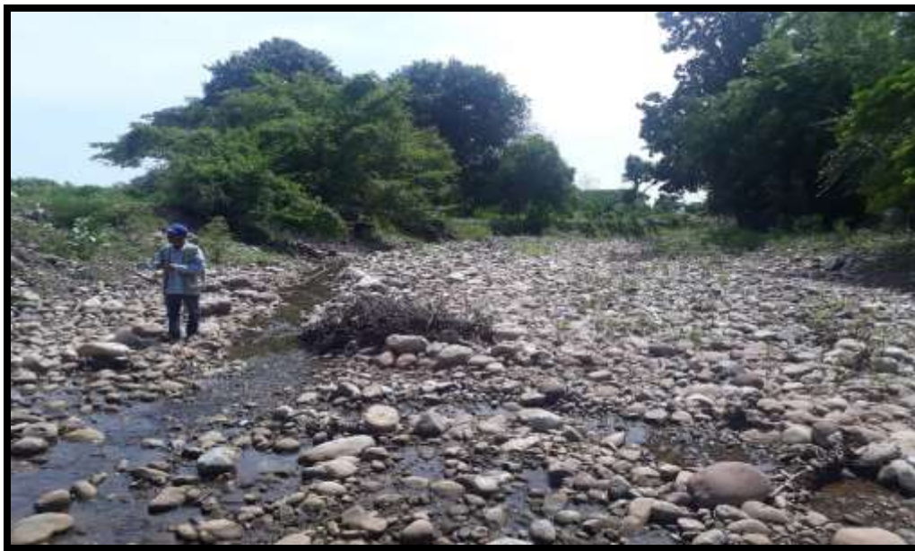
Fotografía No 3 Último tramo de agua en el cauce del río chiriaimo en el sector conocido como La Estancia justo antes del inicio de los muros de contención. (Coordenadas 1099530E, 1635405N)
